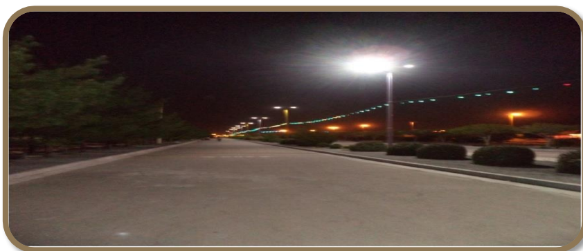
بعد از اجرا
